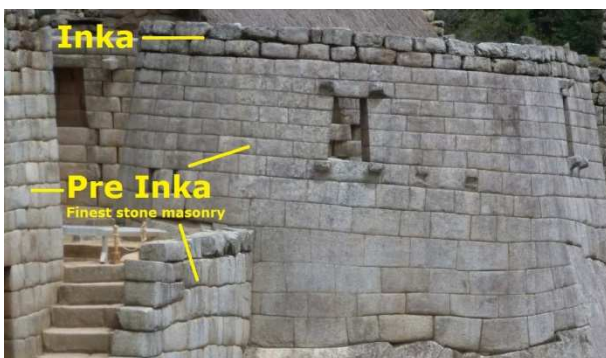
Beide Aufnahmen wurden in Machu Picchu gemacht. Man beachte die perfekte Steinbearbeitung der unteren Strukturen und das grobe Inkabauwerk darüber.
